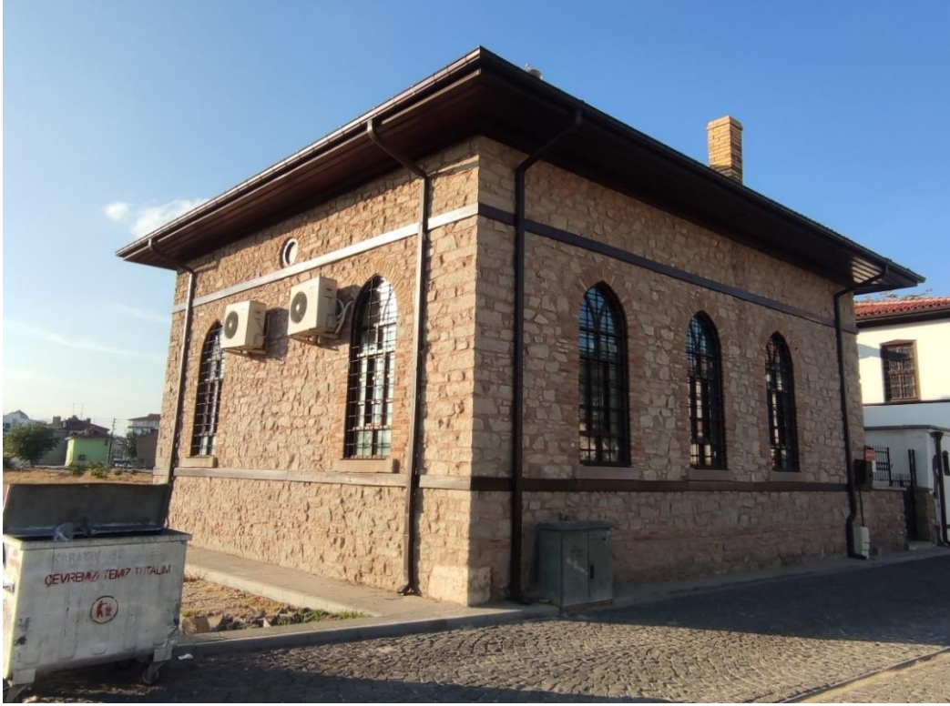
Fotoğraf 3: Hacı Ömerler Camii Güneydoğu Cephe Görünüşü.
