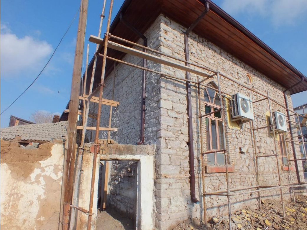
Fotoğraf 6: Hacı Ömerler Camii Güneybatı Cephe Görünüşü.
