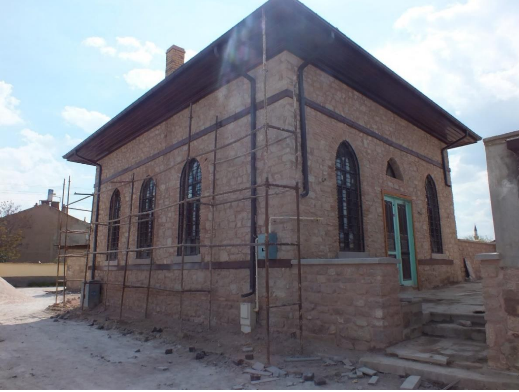
Fotoğraf 9: Hacı Ömerler Camii Kuzeydoğu Cephe Görünüşü.
