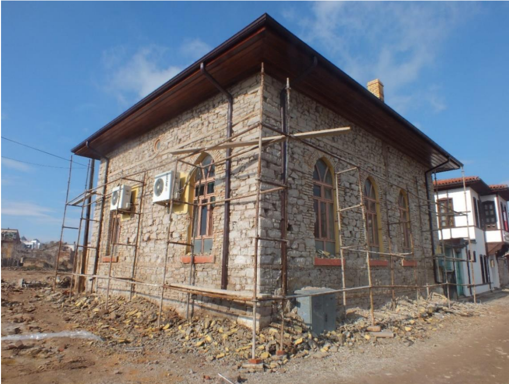
Fotoğraf 2: Hacı Ömerler Camii Güneydoğu Cephe Görünüşü.
