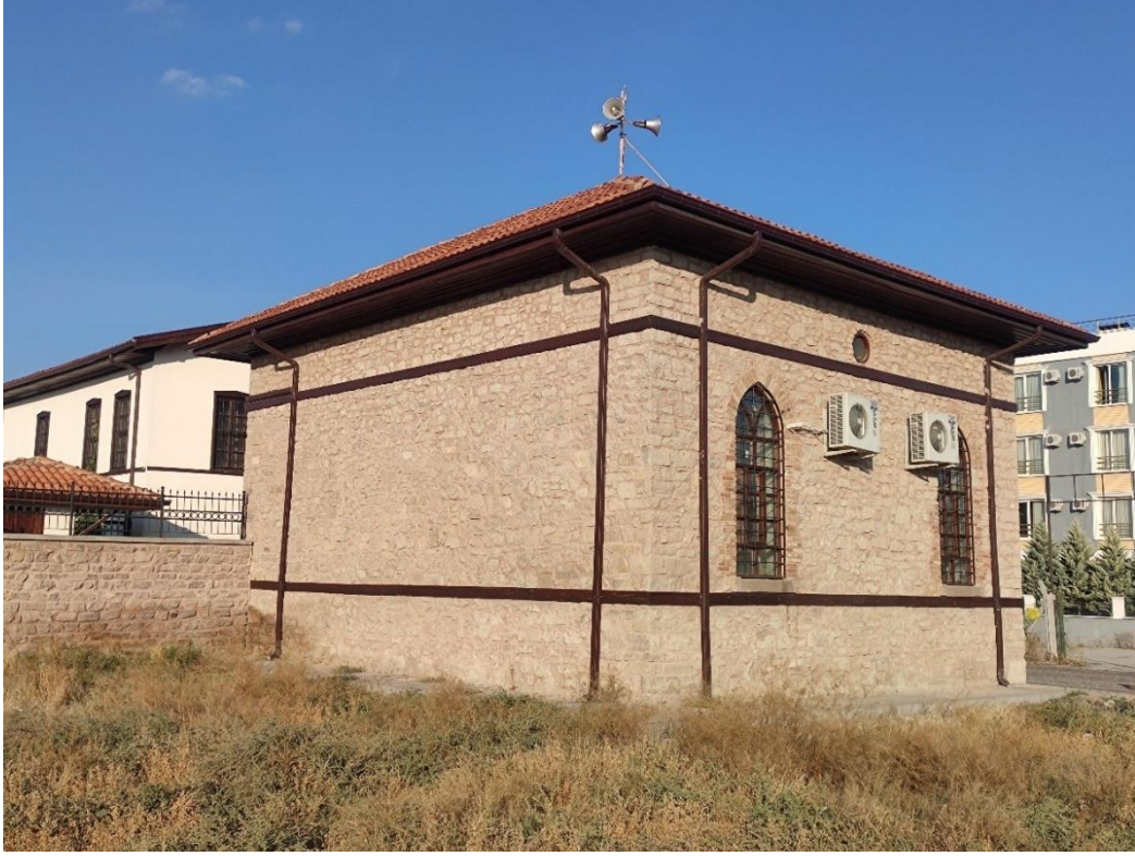
Fotoğraf 7: Hacı Ömerler Camii Güneybatı Cephe Görünüşü.
