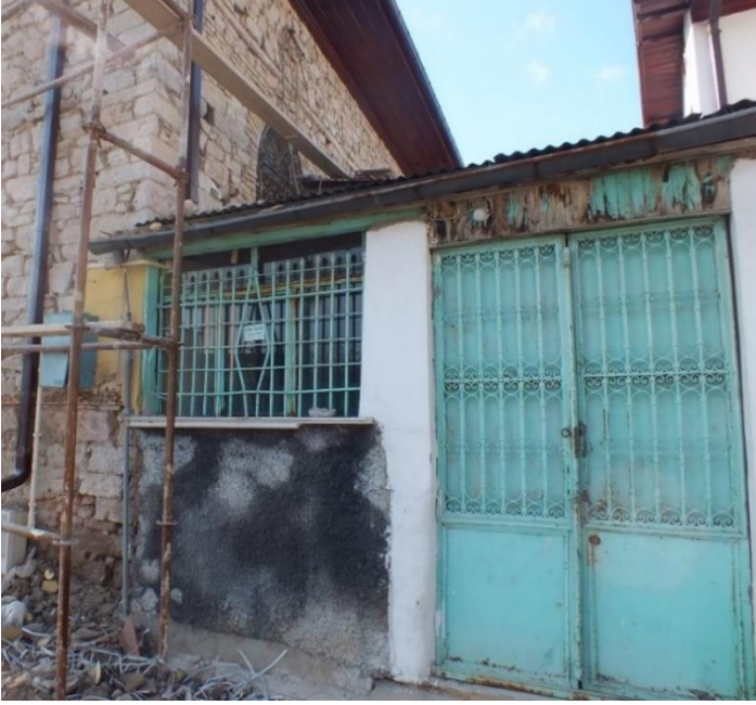
Fotoğraf 13: Hacı Ömerler Camii Avlu Görünüşü.
