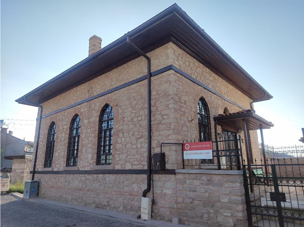
Fotoğraf 10: Hacı Ömerler Camii Kuzeydoğu Cephe Görünüşü.
