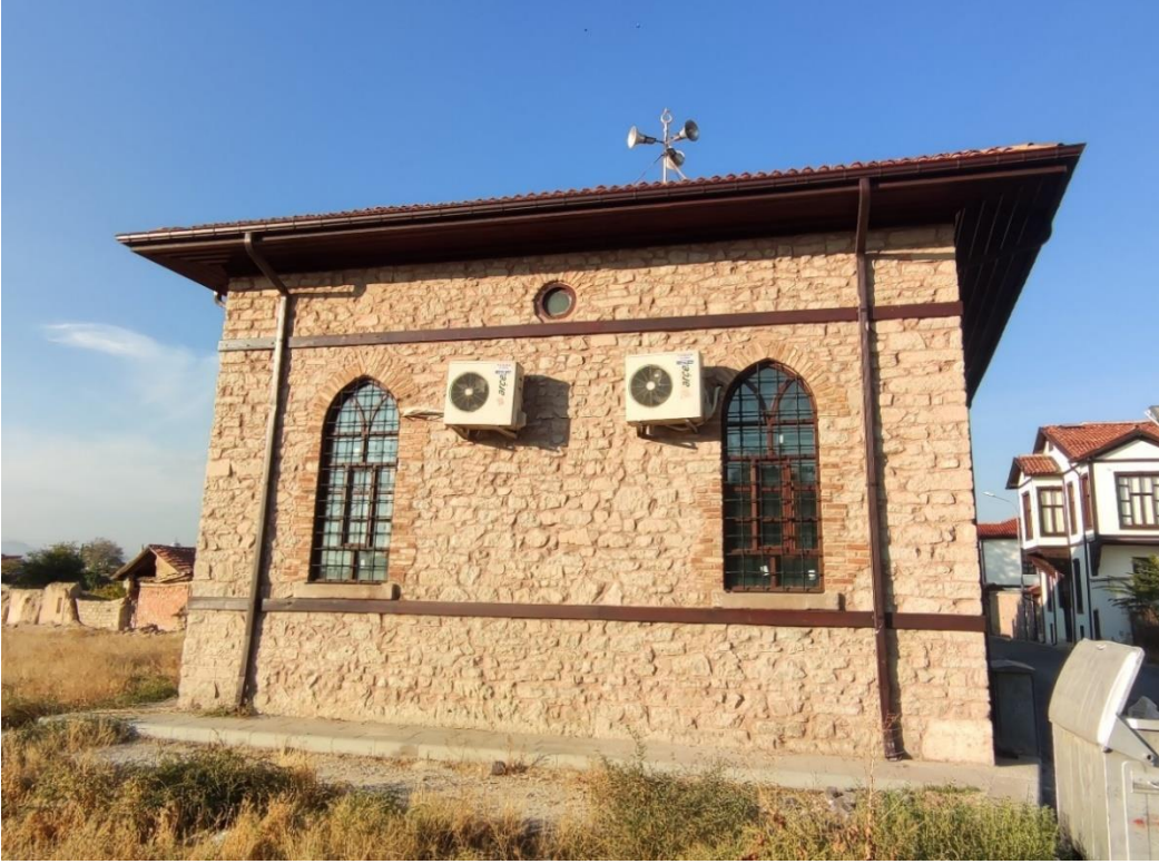
Fotoğraf 5: Hacı Ömerler Camii Güney Cephe Görünüşü.
