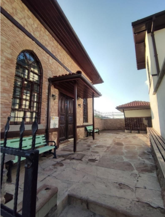
Fotoğraf 14: Hacı Ömerler Camii Avlu Görünüşü.
