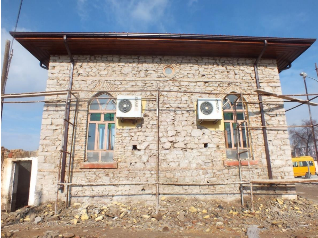
Fotoğraf 4: Hacı Ömerler Camii Güney Cephe Görünüşü.
