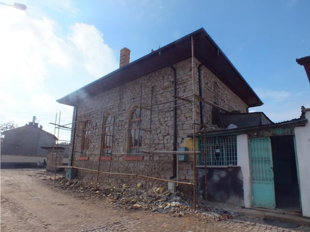
Fotoğraf 8: Hacı Ömerler Camii Kuzeydoğu Cephe Görünüşü.
